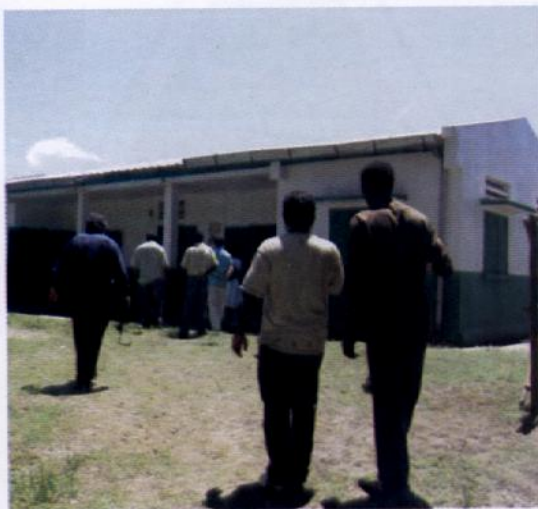
EPP nouvellement construite CR Ampasy, Région Anosy
